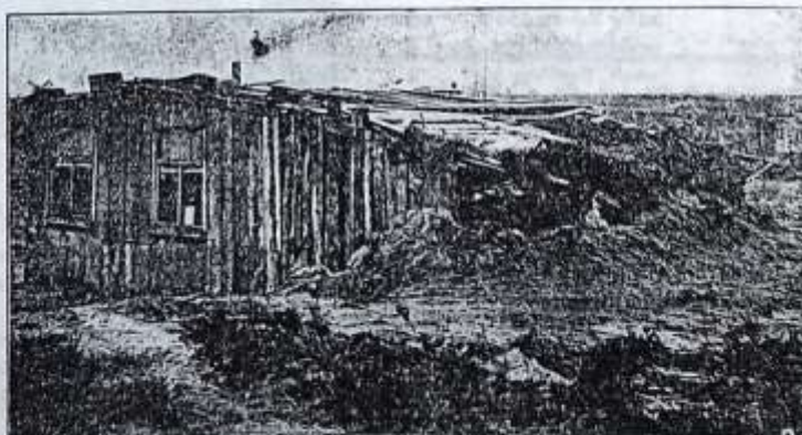
Foto wettelijk afgegaan door de „Werkdoorniek“
