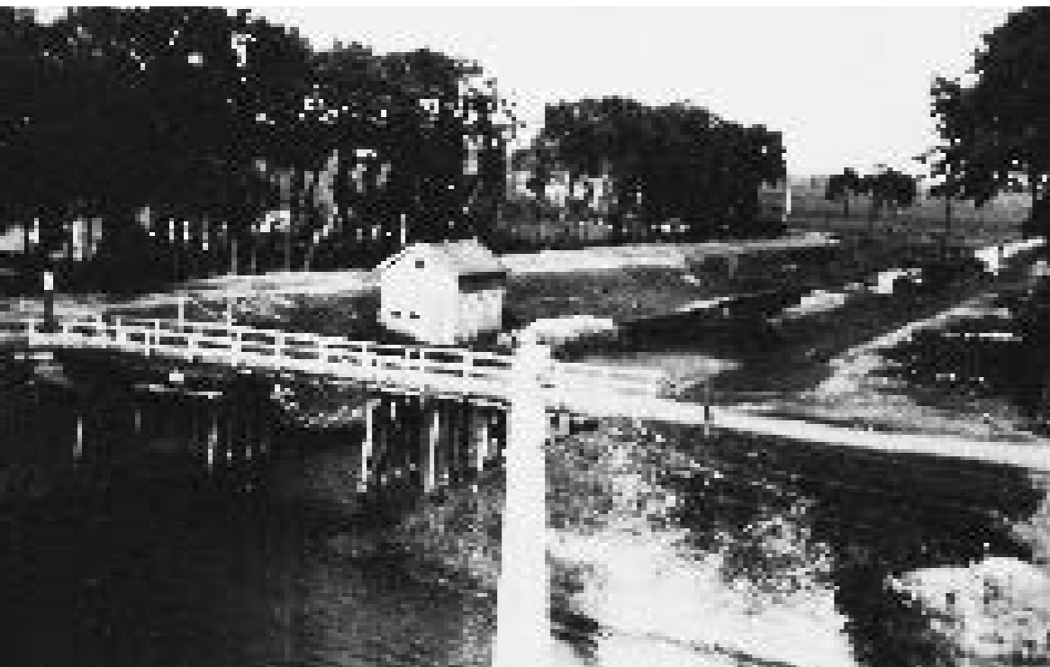
Verbindingswijk met de Wijksluis, brug en gemaal. Archief Sis Hoek-Beugeling.
