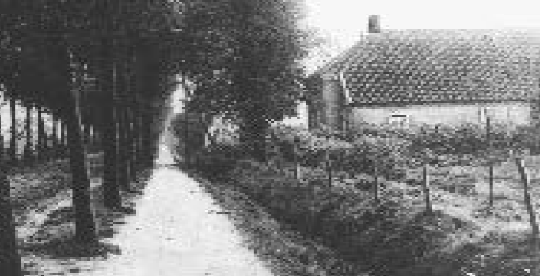
De Angelsloërdijk met apart fietspad, met daarnaast een 'telefoonpaal' voor de leiding van het bovengronds elektriciteits- of het telegraafnet. Karren krijgen niet de kans het smallere fietspad kapot te rijden. Foto: Gemeente-archief Emmen.
