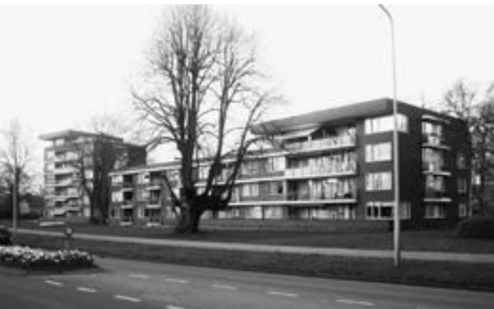
Op de plek van het vroegere Rosinghe-erf staat nu het appartementengebouw Semester (links) en vermoedelijk een deel van Trimester (rechts). De rest van Trimester staat op het Jipping-erf. Foto: André Dekker.
