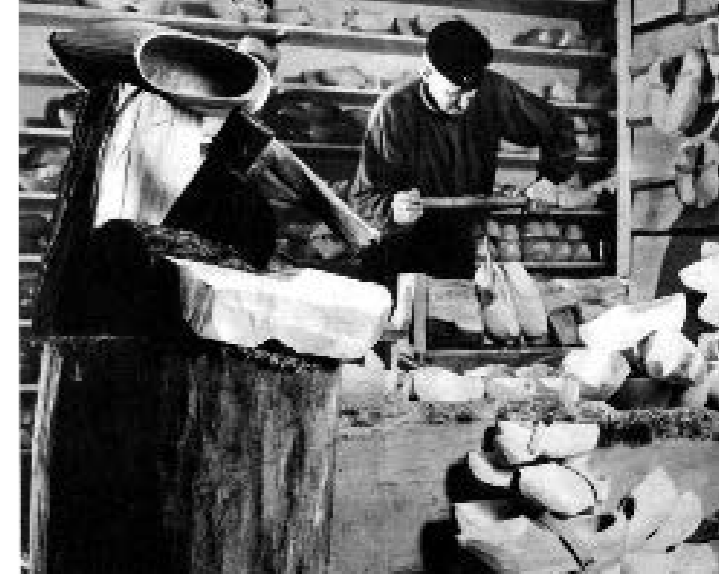
Een klompenmaker in zijn klompenmakerij bezig met het uitboren van een klomp (uit: De Spiegel, 11 juli 1964, foto Paul Huf, gemaakt in opdracht van de Grolsche Bierbrouwerij N.V.).
