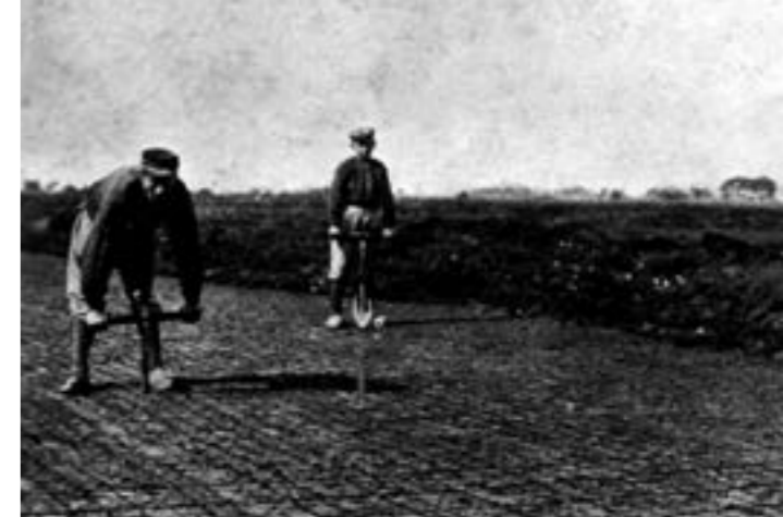
Het steken van de baggerturf met het steekijzer (coll. P. Naber)
