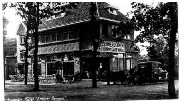
In het voormalige Hotel Emmer Dennen, in de jaren twintig gebouwd op de hoek Boslaan/Dennenlaan en na de Tweede Wereldoorlog o.a. in gebruik als "Bejaardensociëteit" , kwamen de heren tussen 1968 en 1995 bijeen.
