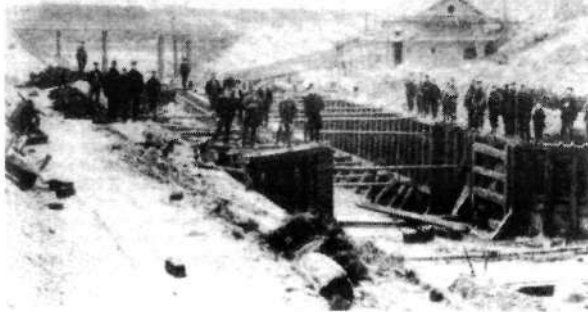
De Oranjesluis in aanbouw bij de monding van de Bladderswijk in het Van Echienskanaal. Rechts het stoomgemaal.
