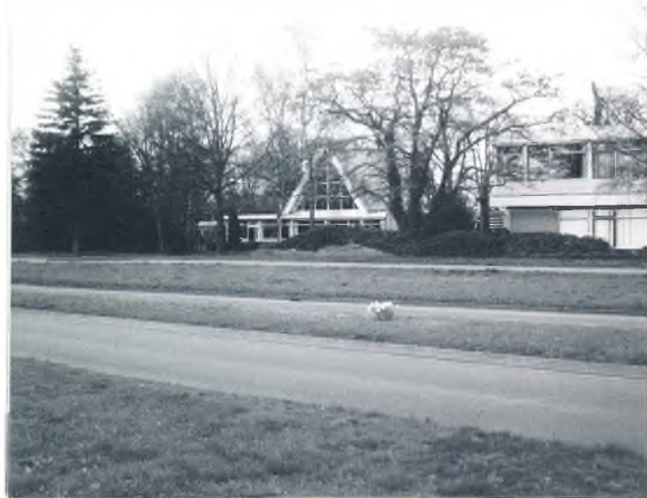
Op de plek van het Jipping-erf staat nu een deel van het appartementengebouw Trimester (links nog net zichtbaar) en een deel van de gebouwen van het Drenthe College. Foto André Dekker.
