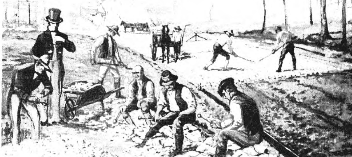
De aanleg van de eerste macadamweg in 1823 in de Verenigde Staten. Op dezelfde wijze zijn deze wegen in Nederland aangelegd.
