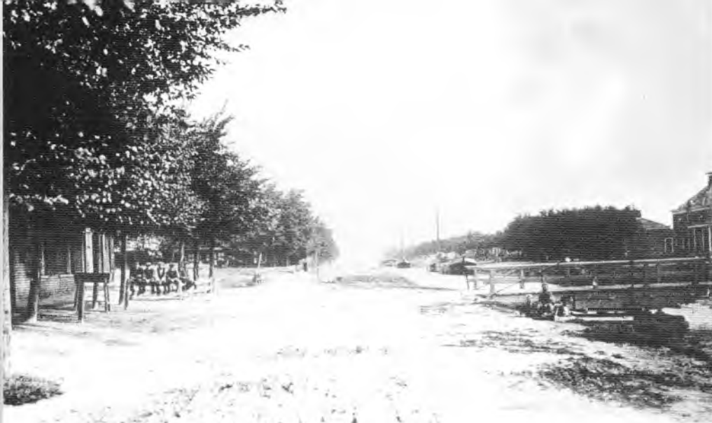
Nieuw-Weerdinge omstreeks 1900. Omge- ving Eerste Kruisdiep. De houten brug uit 1889 werd in 1912 vervangen door een ijzeren brug. (collectie Gemeente Archief Emmen)
