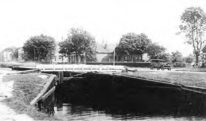
De Heemskerksluis vóór de Tweede Wereldoorlog. Duidelijk is het houten bruggetje te zien, waarover men van de ene naar de andere kant van het kanaal kon gaan.
