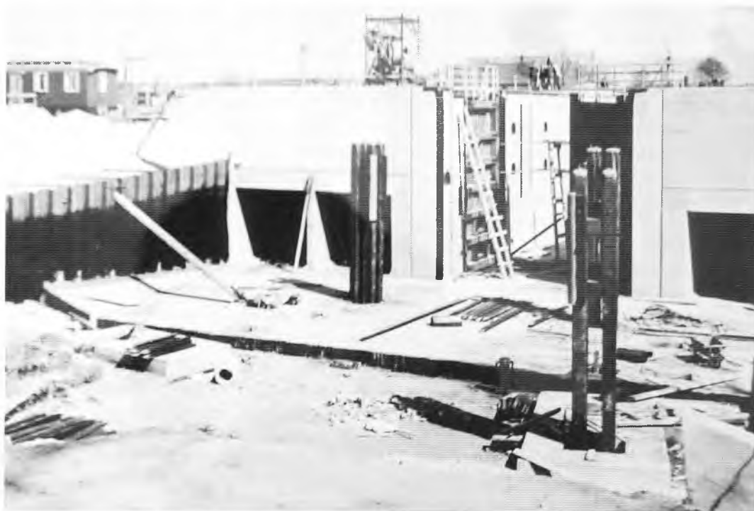
Boven: De bouwput van de nieuwe Ericasluis met het gezicht op het benedenhoofd tijdens het aanbrengen van de stortebedden. Aan weerszijden van de doorvaart de instromingopeningen der aflaatwerken. (Drents Archief, no. DSC 00795)
