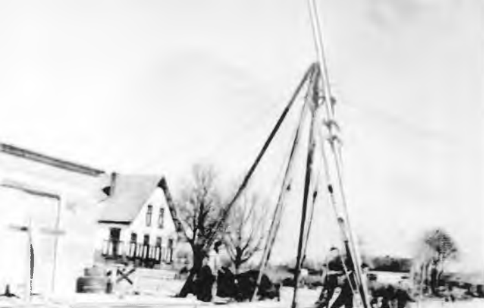
Het inbrengen van betonnen damplanken ten behoeve van de nieuwe Ericasluis door middel van spuiten en naheien. Links van de heistelling het witte huis van de landbouwer C. van de Capelle. Thans bevindt zich in dat pand het Bloemenhuis, Verlengde Vaart NZ 28, van A. Lubbe. (Drents Archief, no. DSC 00797)
