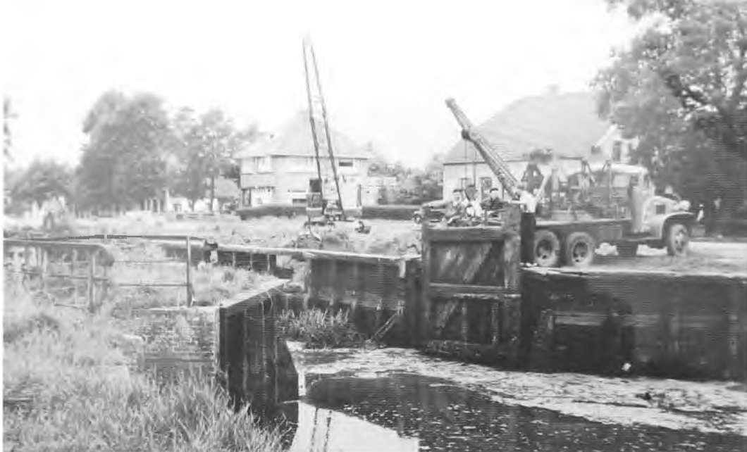
De afbraak van de Heemskerksluis. Op de afbeelding is een kraanwagen bezig een van de oude houten deuren van deze sluis op te hijzen. Een drag-line staat gereed om de sluiswand te ontgraven. Rechts het zogenaamde 3de Mensinghuis, voorheen café Nijman (Drents Archief, no. DSC 00800)
