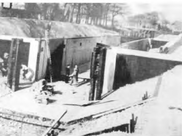
Links: De bouwput van de nieuwe Oranjesluis. Tegelijk met de bouw van de Ericasluis werd in het Oranjekanaal nabij Klazienaveen een nieuwe sluis gebouwd ter vervanging van de oude, die omstreeks 1885 was gebouwd. (Drents Archief, no. DSC 00834)
