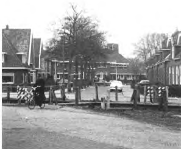
Door de 'sluisjes' konden alleen fietsers en voetgangers nog gebruik maken van de onbewaakte spoorwegovergang. (Foto: Johan Withaar)
