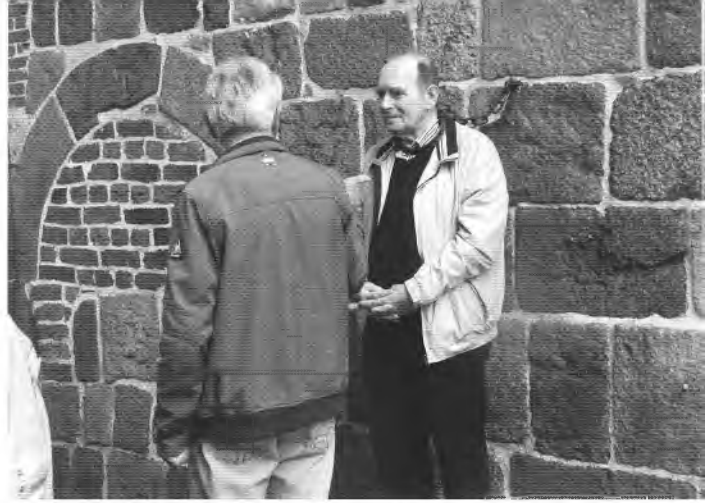
Harm Joling (rechts) staat aan de schandpaal te praten met Jans Wierts. Je stond in Remels dus aan de schandpaal naast de ingang van de kerk. Naast Harm is een oude dichtgemetselde ingang van de kerk zichtbaar. Je kunt duidelijk zien dat mensen toen aanmerkelijk kleiner waren. (Foto: Henk Jeurink)
