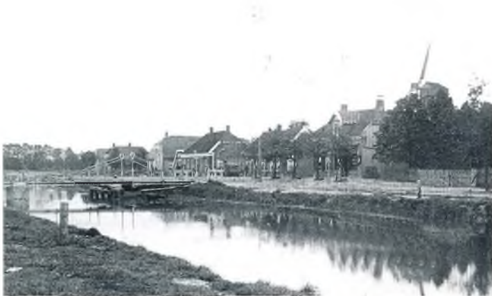
Erica. Links van het pand dat in de lengte staat is nog net een stukje van de smederij van Hof te zien (Collectie Historische Kring Erica).
