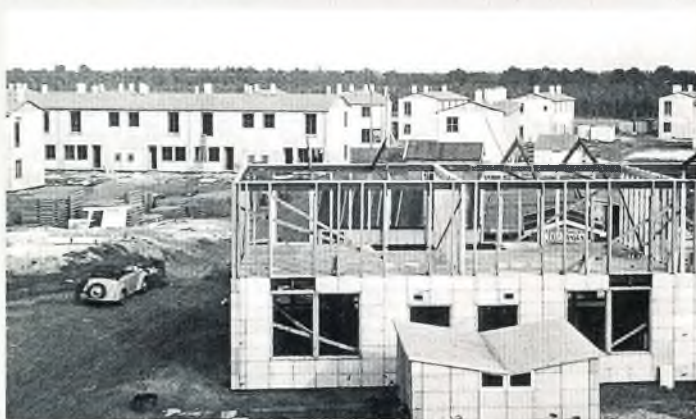
Boven: Airey-woningen in aanbouw in Emmenmeer (Foto's: Gemeentearchief Emmen)
