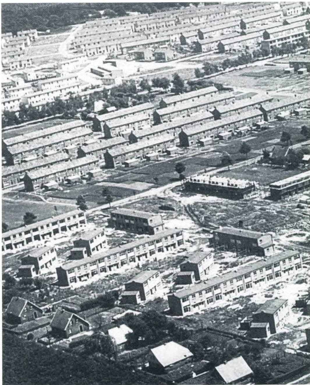
Er is/wordt stevig gebouwd ten noorden van de Haagjesweg. Onderaan de foto de IJsselsteinwoningen, in het midden de Keerpuntwoningen en boven de Airey-woningen. Foto is van 1952. (Collectie Gemeente-archief Emmen)
