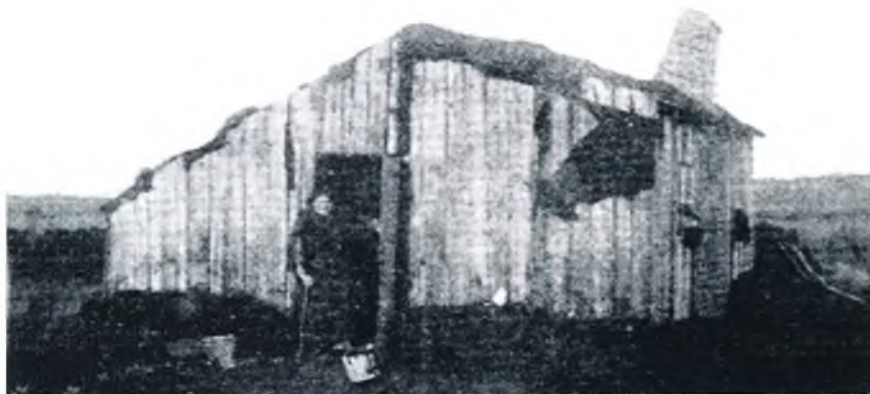
Nog zoo'n krot, dat we aantreffen op den weg naar Barger-Compascuum. Het is er donker en kil binnen, door de kieren blaast de wind en uit het dak drupt de regen neer, verkleumd, hongerig schamel gekleed waren de zes bewoners.
