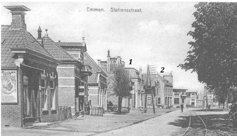
Winkelpanden aan de Stationsstraat (later Hoofdstraat) in de jaren twintig van de vorige eeuw. De tramrails zijn op de foto te zien. Van 1910 tot 1945 reden trams door Emmen naar Ter Apel. De meeste panden, links op de foto, zijn inmiddels afgebroken. De panden die Jan Van Peer in 1910 (1) en 1916 (2) liet bouwen zijn op deze zichtbaar te zien. (Collectie Roelof Boelens)
